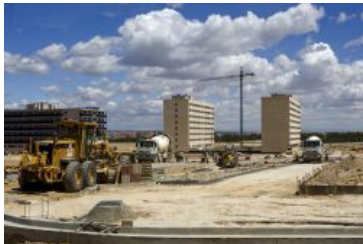
Una vista de las obras del nuevo barrio residencial de Arcosur, en Zaragoza.
