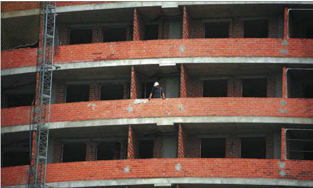
Viviendas a medio construir en el distrito de Quatre Carreres, en Valencia. / JESÚS CÍSCAR
