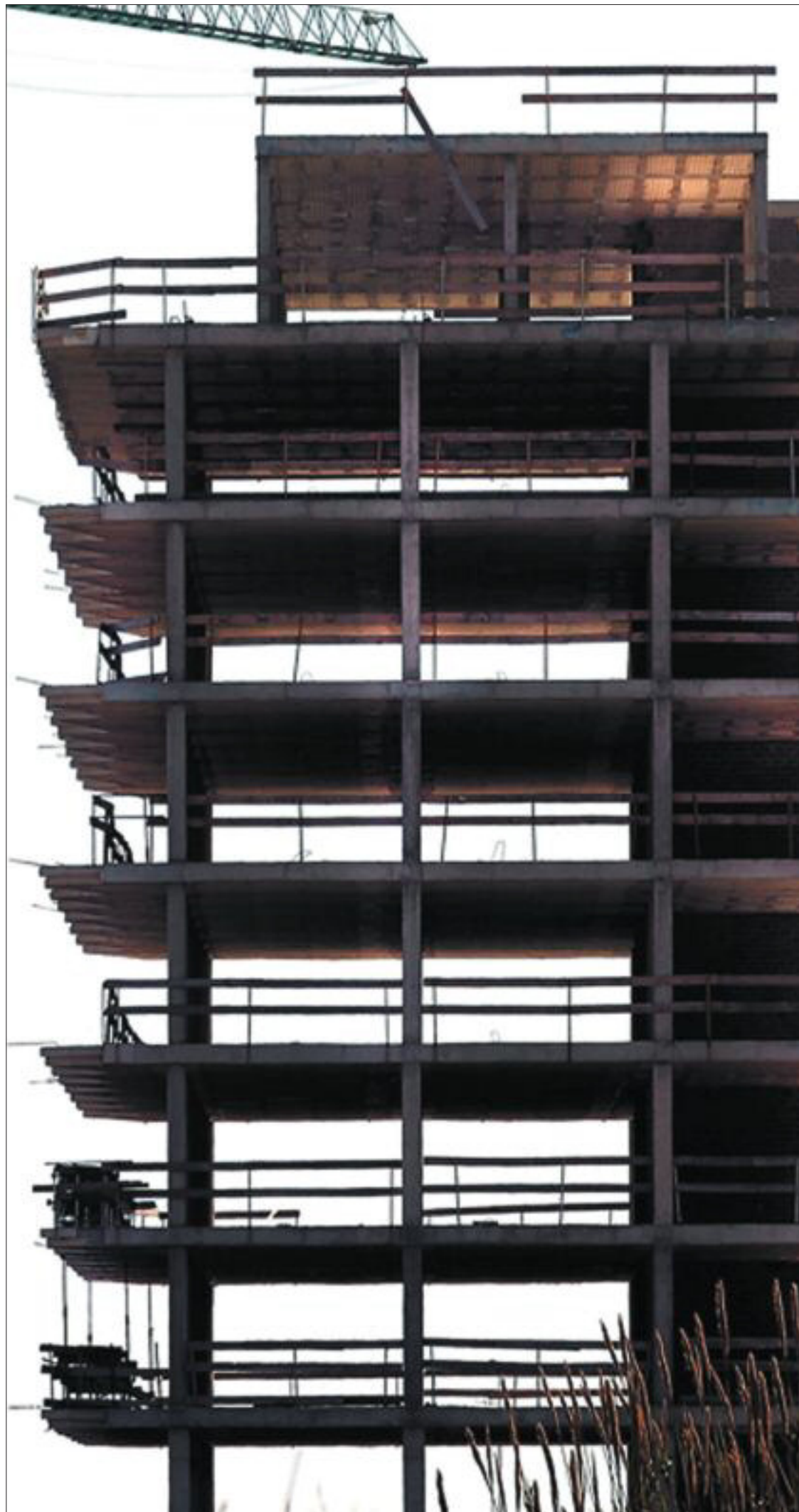
Cajas y bancos tienen 150.000 millones de euros en activos inmobiliarios problemáticos. / SANTIAGO CARREGUI
