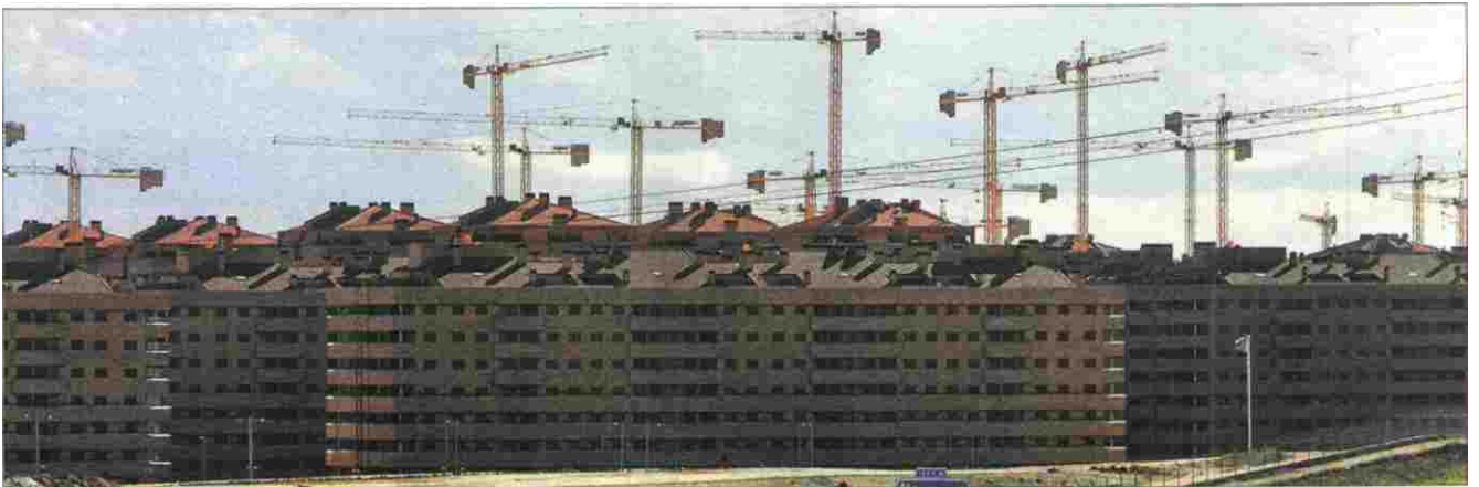
Vista de bloques de viviendas en construcción en el término de Seseña (Toledo) del constructor Francisco Hernando, "El Pocero". / ULY MARTÍN
