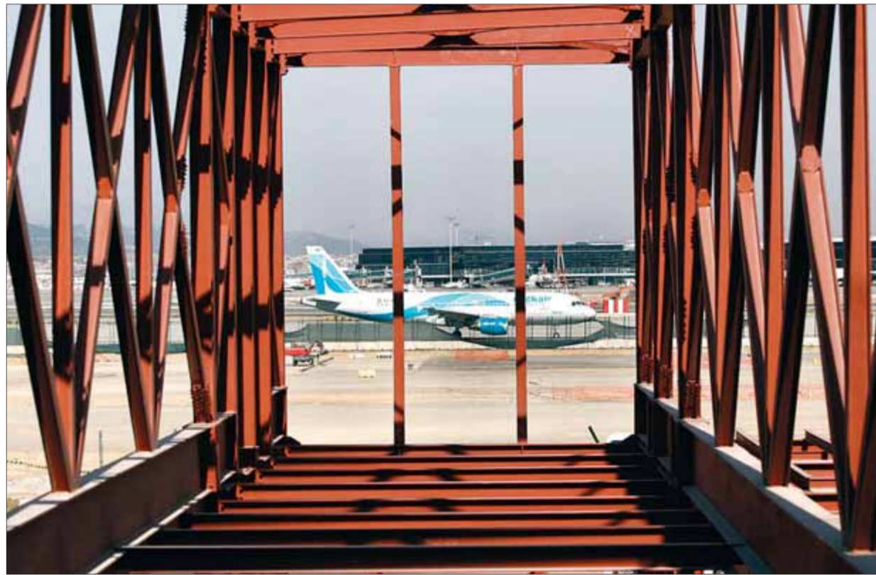
Un avió de Clickair circula per davant d'un "finger" en construcció de la terminal Sud ■ CRISTINA CALDERER / ARXIU
