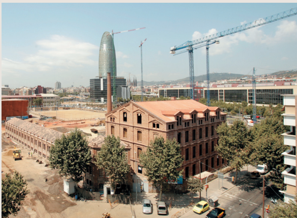
VISTA DE LES OBRES DEL NOU CAMPUS, A CA L'ARANYÓ
