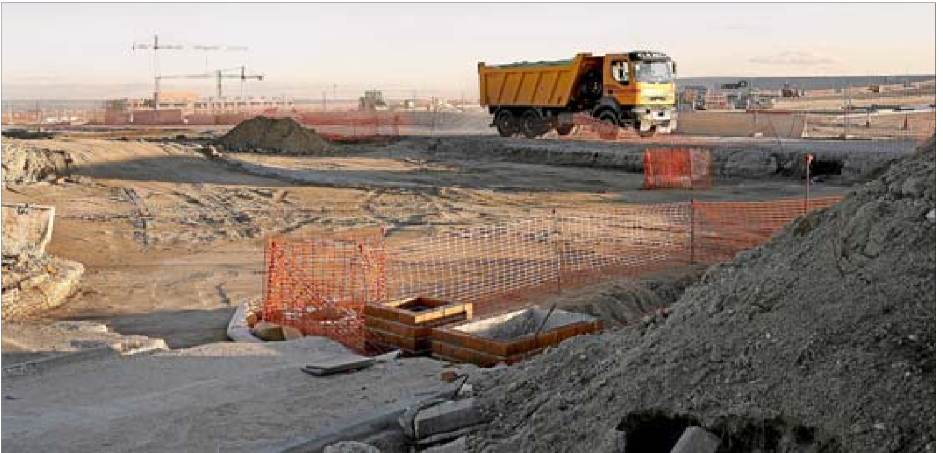
Obras de urbanización en el PAU de Valdebebas. / SERGIO ENRÍQUEZ
